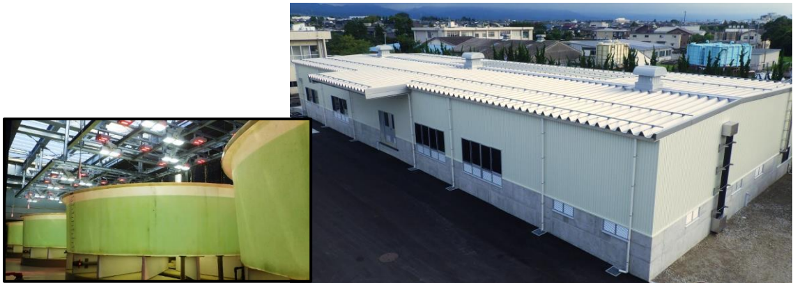
水産研究所のキジハタ・アカムツ種苗生産施設（令和元年8月竣工）
