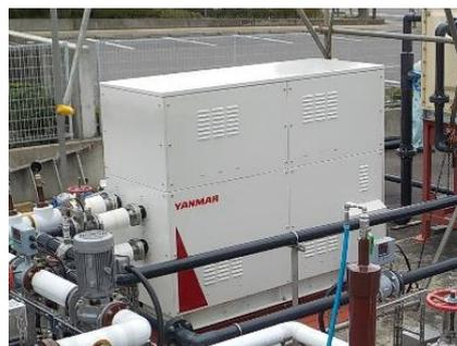
図 2-18 温泉排熱を利用した小型発電システム
