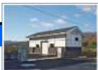
山田新田用水発電所 [南砺市]
