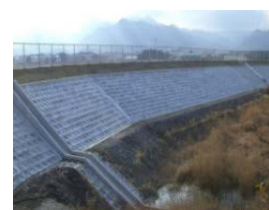
【防災工事(堤体の補強)】
