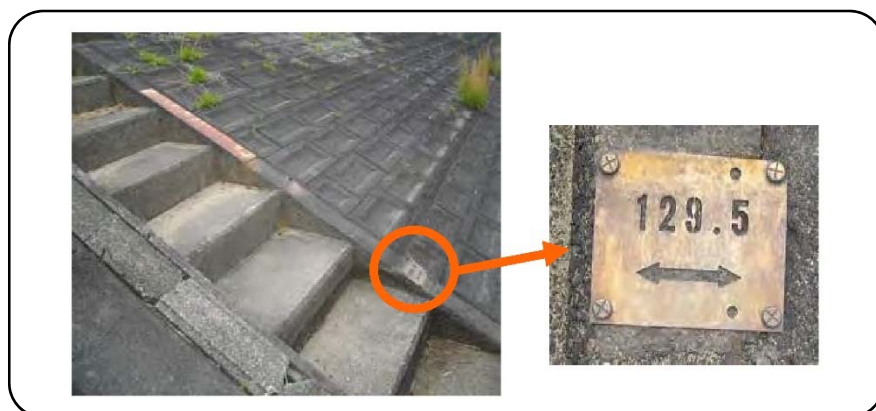
【図 4-6：管理用階段に設置された満水位プレート（柿下ため池）】
