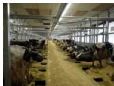
写真1 新築した牛舎（内部）
