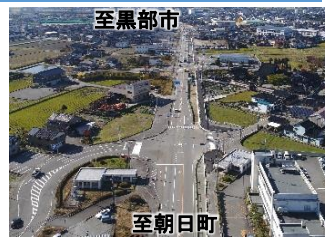
国道8号入善黒部バイパス
