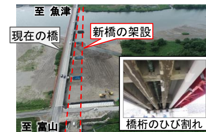
県道富山魚津線 今川橋の架替
