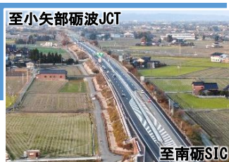
4車線化の一部供用区間
