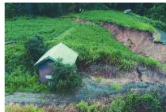
岩瀬 地すべり対策(R3.8災害発生)
