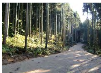
作業道の整備
