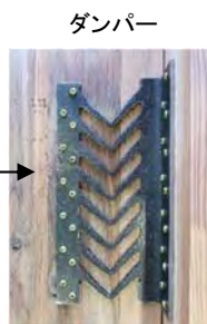
ダンパー付き CLT 耐力壁
