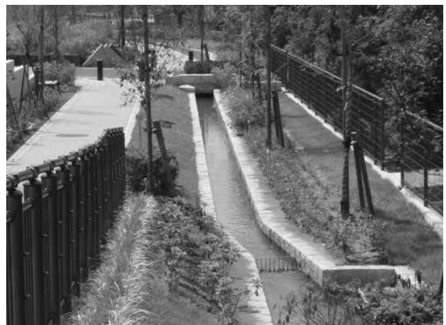
射水市 小杉駅南せせらぎ水路
