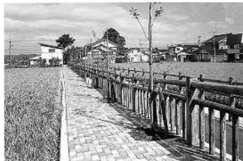
溶融スラグを有効利用したインターロッキングブロック（溶融スラグを有効利用した製品）
