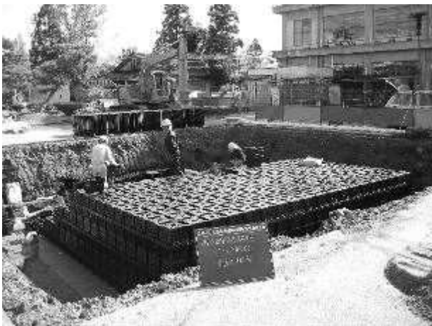
立山町 雨水貯留浸透施設の整備 (立山町役場駐車場)
