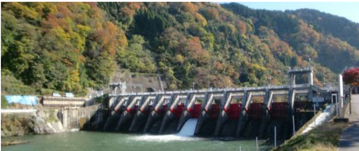
庄川合口ダム（庄川合口堰堤）
