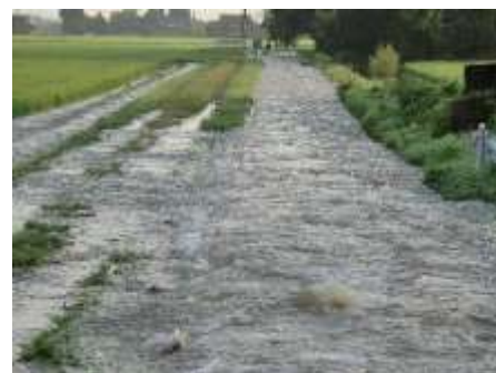
溢水した農業用水路(高岡市)
