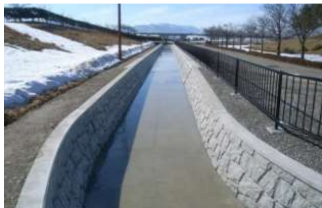
老朽化対策された用水路(砺波市)
