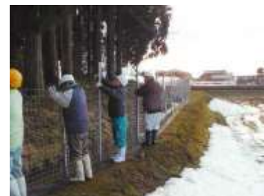
耐雪型侵入防止柵の設置
