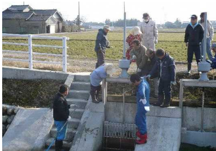
水門の保守・点検管理の様子
