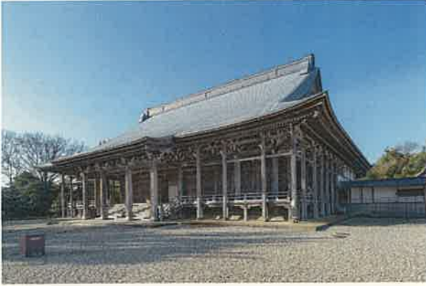
近世に隆盛した建登せ柱や軒支柱の技法を高度に駆使
