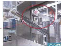
水栓のレバーもきれいに清掃。きれいな状態で、備品も汚れの無い状態で管理。
