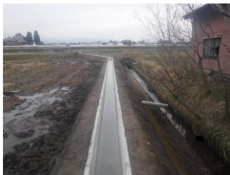
農業用水路の改修
