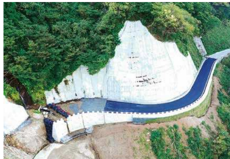
(株)ユアネクス施工の「県営林道開設別又嘉例沢線一ノ又谷工区開設工事」
