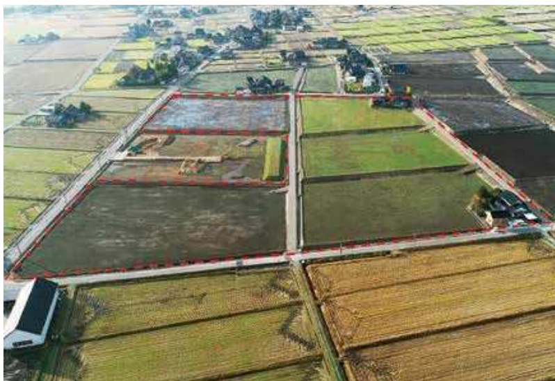
(株)丸泉施工の「ほ場整備祖谷二期地区ほ場整備第3工区工事」
