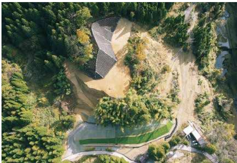
丸新志鷹建設(株)施工の「緊急地すべり防止（虫谷）排土工ほか工事」
