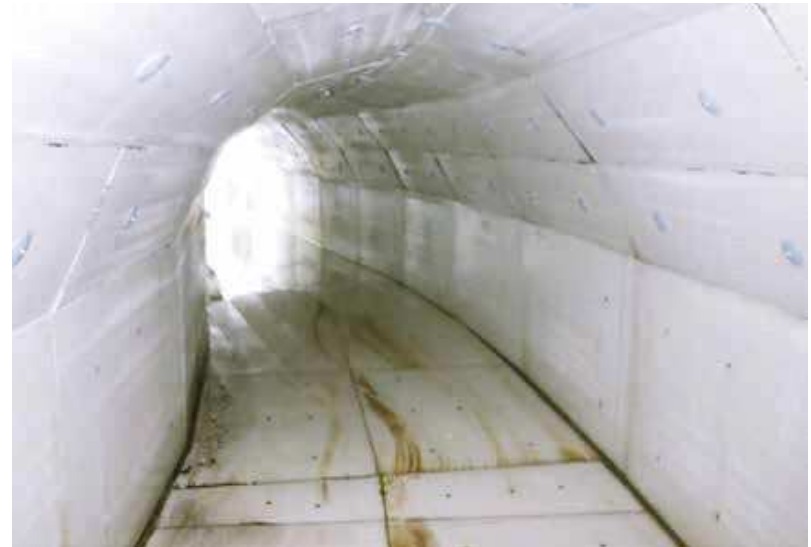
水新建設(株)施工の「用排水施設整備薄波地区舟倉用水路その 1 工事」
