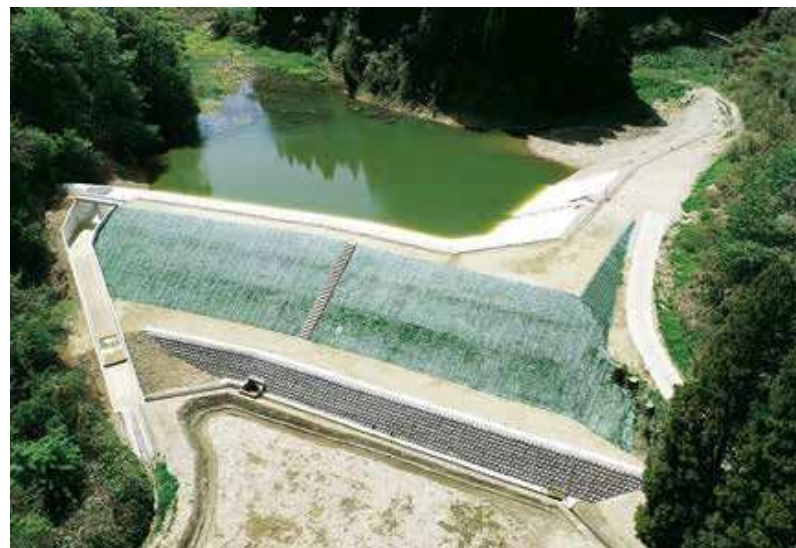
(株)干場建設施工の「県営農村地域防災減災事業谷内山池地区 谷内山池堤体改修工事」
