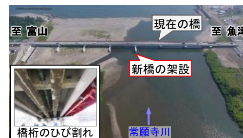
県道富山魚津線 今川橋の架替
