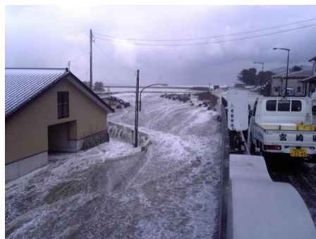
図 7-35 寄り回り波による被害 (平成 20 年 2 月、宮崎漁港海岸)
