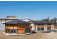
最優秀賞 富山県立大学 学生会館 建築主 公立大学法人 富山県立大学 設計 富山県立大学新棟新築工事 三四五・福見設計共同体 施工 塩谷建設・高田建設 富山県立大学学生会館新築工事共同企業体
