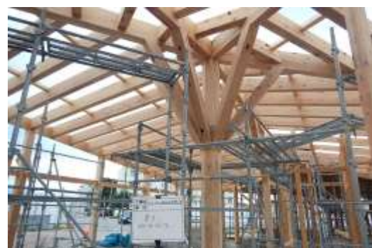
建て方の様子。八角形の柱と樹状方柱は大工の手刻み加工で、立体的な仕口を削り出している。
