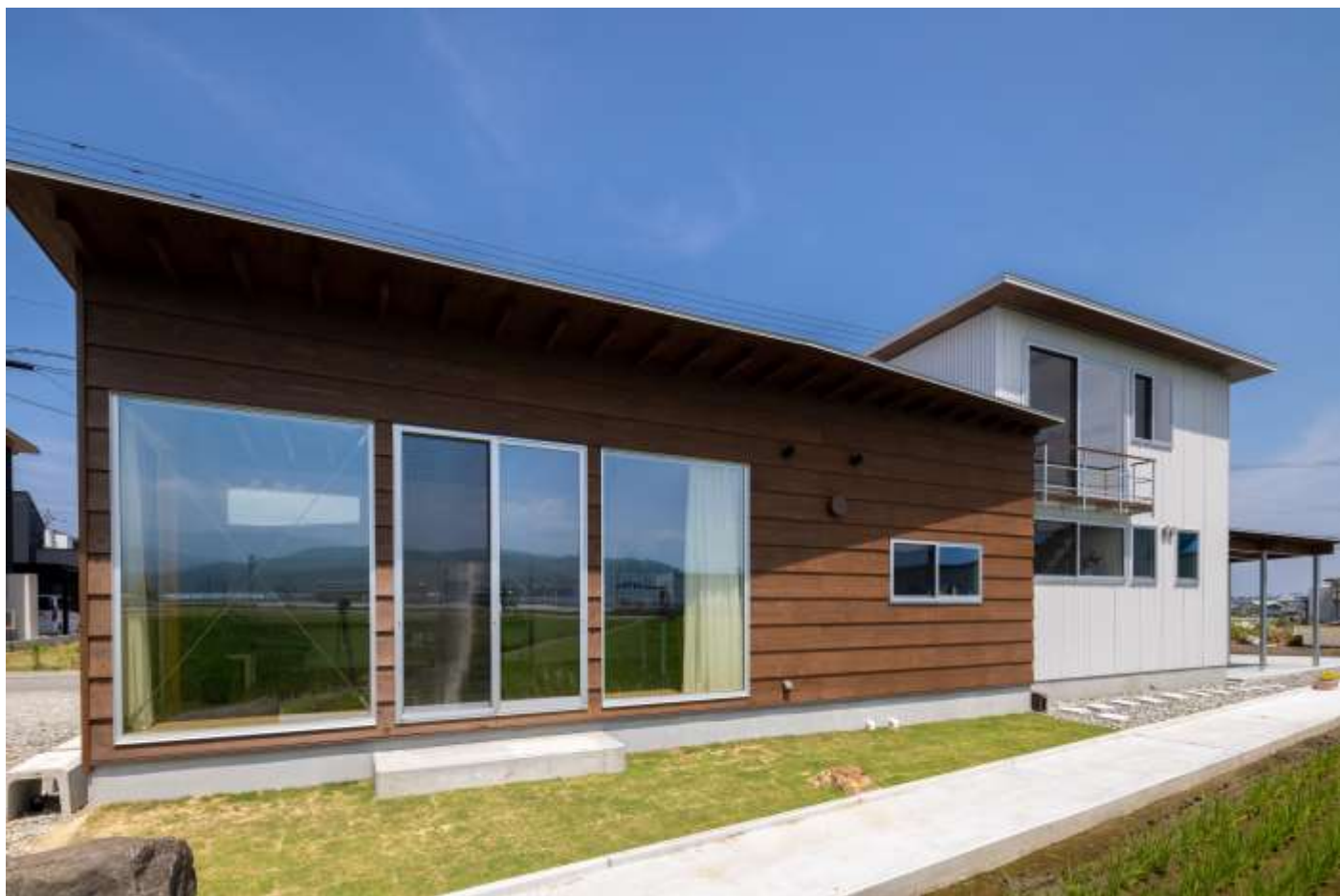
東側外観。幅広の下見板と、白いガルバリウム外壁のコントラストが目を引く。
