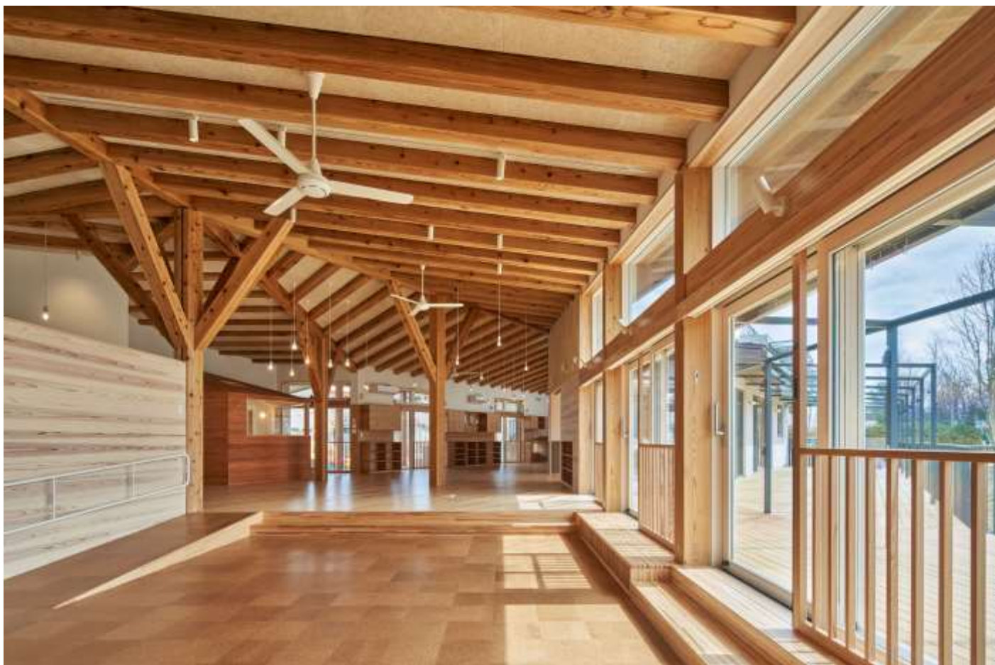
遊戯室から見た保育室。構造は準耐火構造の燃え代設計とし、県産スギ製材の軸組構造を現しにしている。（写真：Koji Fujii / TOREAL）
