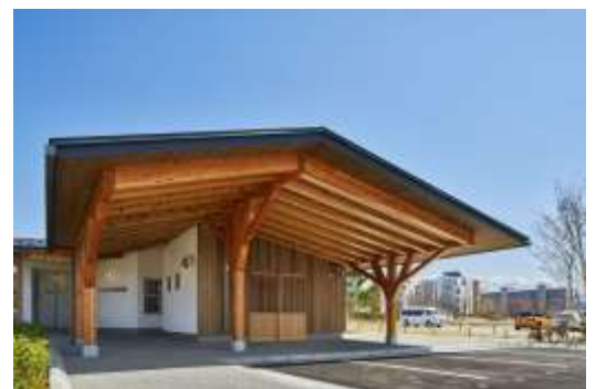
エントランスアプローチ。切妻屋根を持ち出し、車寄せを形成している。雨の日でも車から濡れずに左のエントランスにアクセスできる。（写真：Koji Fujii / TOREAL）
