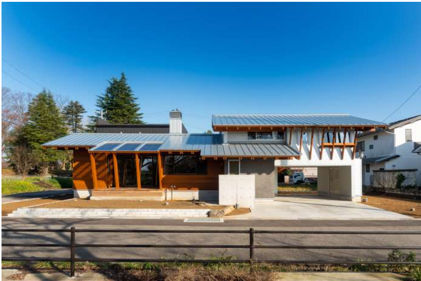
外観。太陽光のパッシブコントロールを行うため、軒を大きく出している。軒から覗く二連の登梁が、構造への興味を引き立てる。
