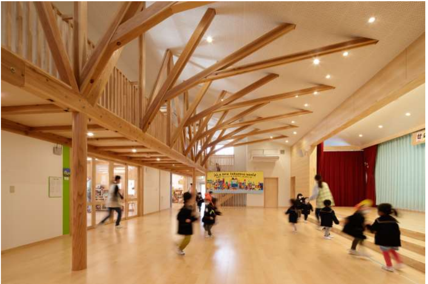
遊戯室。樹状方杖架構によって大空間を支えている。木材で樹を表現し、樹の下で児童が遊ぶ姿はまさに木育といえる。
