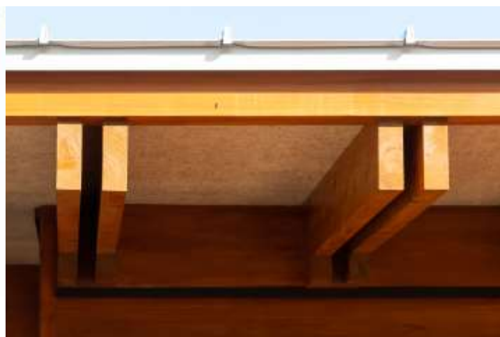
リビング天井。登梁は嵌合せ梁により構成している。キャンチレバー構造とし棟木をなくした架構は、意匠的・経済的にシンプルなデザイン。
