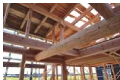
上：外観。 中：リビング・ダイニング。土間からの視点。 下：施工途中。
