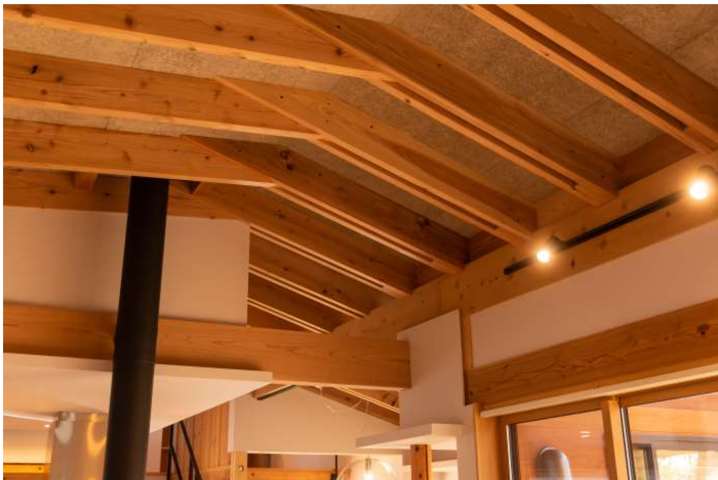
リビング天井。登梁は嵌合せ梁により構成している。キャンチレバー構造とし棟木をなくした架構は、意匠的・経済的にシンプルなデザイン。
