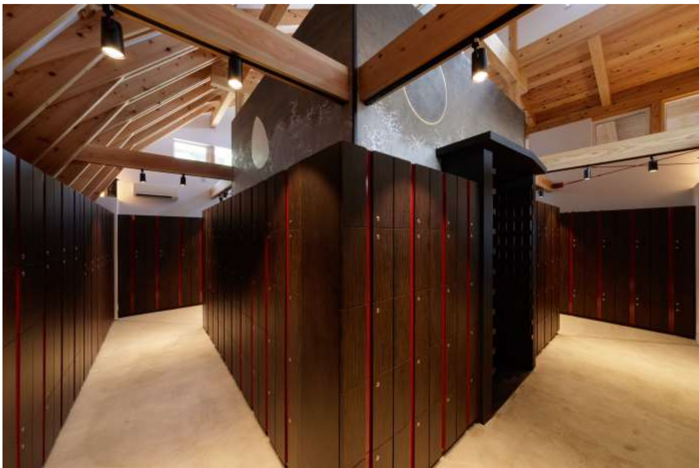
納骨堂。架構はすべて現しとし、富山県産スギを使用している。
