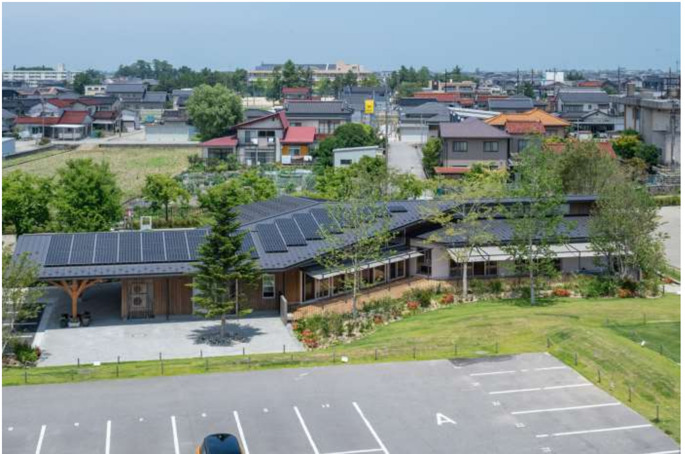
南からの鳥瞰。都市公園のような緑に囲まれた保育園。構造材、外壁に県産材を使用している。太陽光パネル、高気密・高断熱の外皮によりZEBを達成している。
