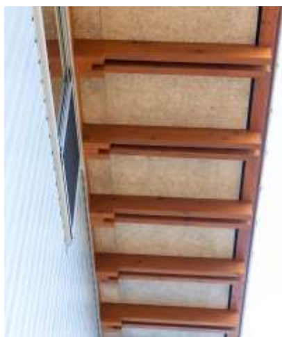
リビング天井。登梁は嵌合せ梁により構成している。キャンチレバー構造とし棟木をなくした架構は、意匠的・経済的にシンプルなデザイン。
