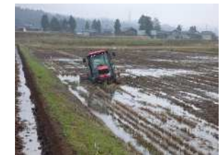
暗渠排水施工箇所
