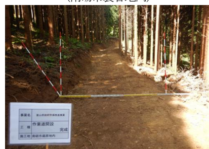
森林整備を推進する作業道開設 (南砺市蔵原地内)
