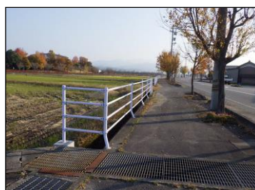
転落防止柵設置状況 (砺波市柳瀬)
