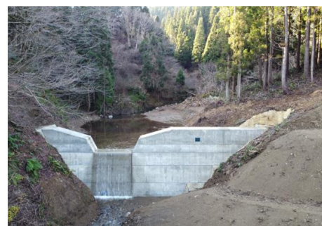
荒廃溪流に谷止工を施行し渓床を安定化
