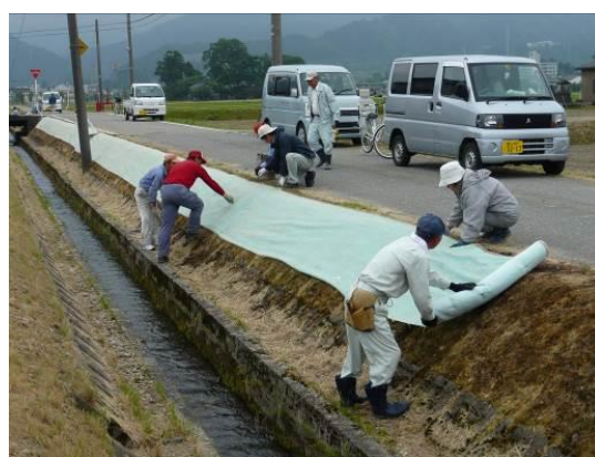
畔カバーシートの張付け（砺波市）
