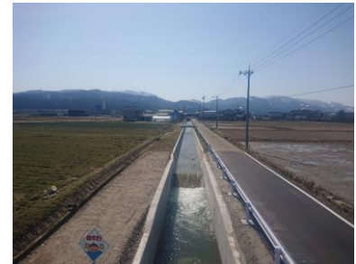
幹線用水路の長寿命化対策 (砺波市太田)
