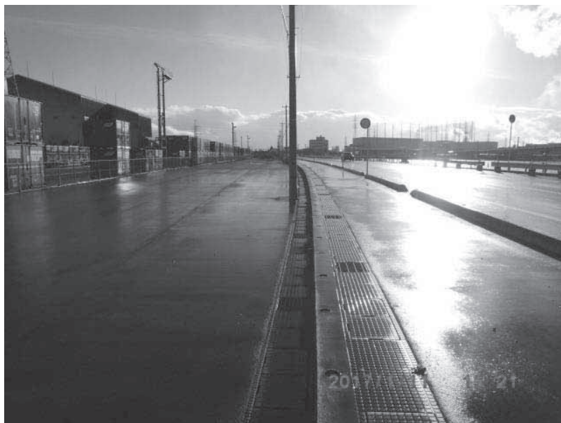
右岸 12 号野積場（平成 29 年 1 月 11 日撮影）
