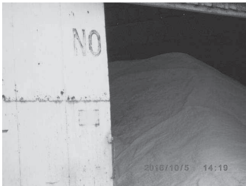
左岸 3 号上屋（平成 28 年 10 月 5 日撮影）
