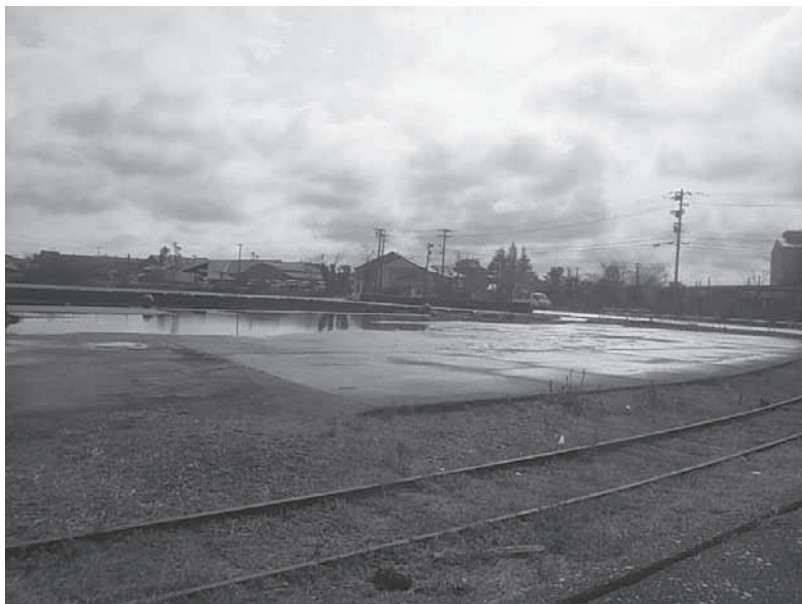
右岸 8 号野積場（平成 29 年 3 月 10 日撮影）
