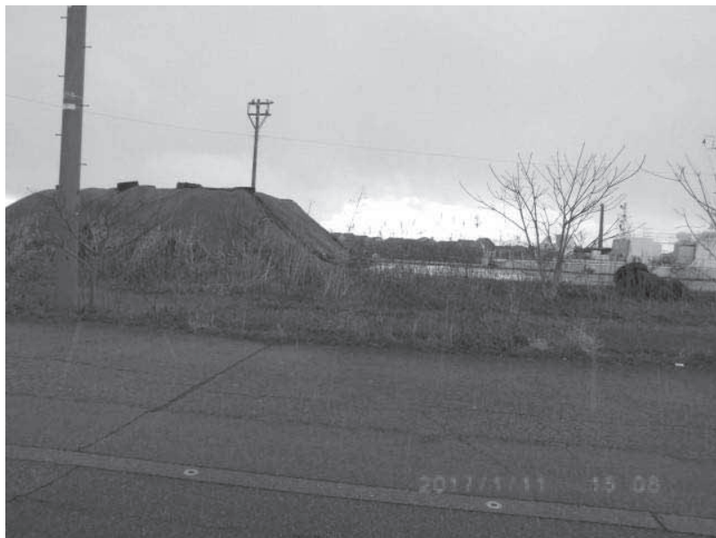
右岸 13 号野積場（平成 29 年 1 月 11 日撮影）
