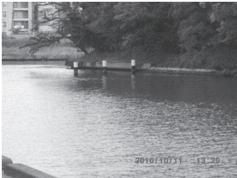
富岩運河整理場（平成 28 年 10 月 11 日撮影）
