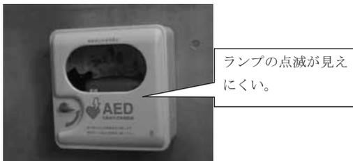
写真-4 収納箱の外からインジケータの表示を確認できない例
