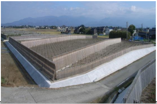
海岸保全対策の推進（入善海岸）
