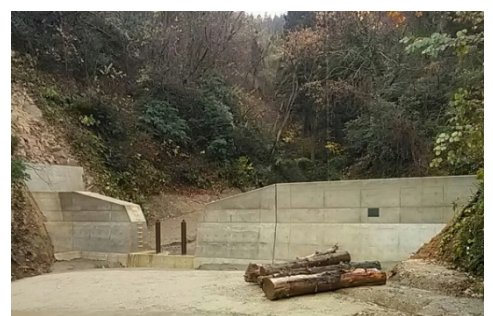
流木捕捉機能を備えた治山ダム (高岡市頭川)
