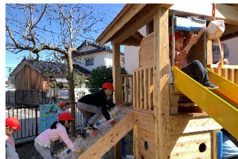
屋外遊具の設置 （富山市藤園幼稚園）
