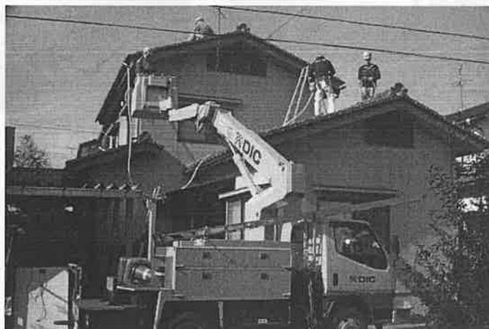
光ファイバー等 通信工事
