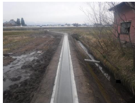
農業用水路の改修
