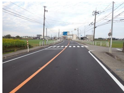
道路の舗装補修(補修後)
