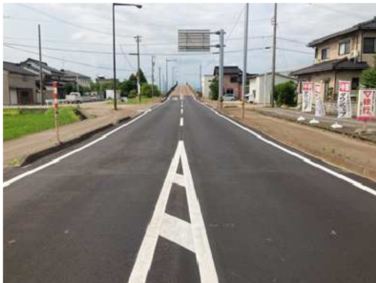
辻建設株式会社 主要地方道新湊平岡線道路総合交付金 (防災・修繕) 舗装補修第2工区工事 発注者 富山県
