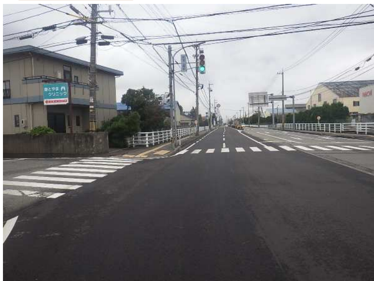
日宏建設株式会社 一般県道八幡田稻荷線道路総合交付金 (防災・修繕) 舗装補修第1工区工事 発注者 富山県
