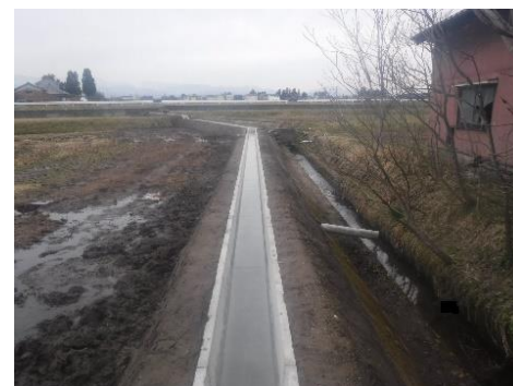
農業用水路の改修
