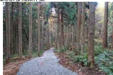
森林作業道の整備
