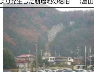
復旧工事完成直後 (H27年12月)
