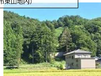
復旧工事完成後3年後 (H30年9月)
