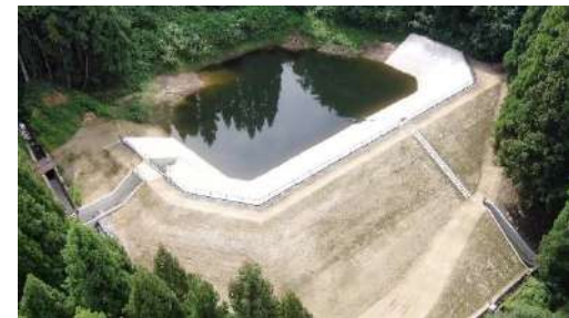
ため池の整備例（R5：美濃輪池地区）
