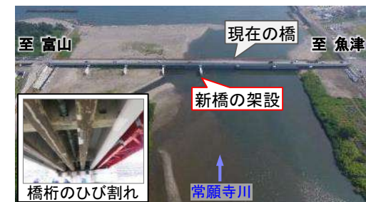
県道富山魚津線 今川橋の架替
