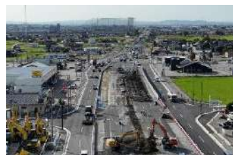
国道8号豊田新屋立体
