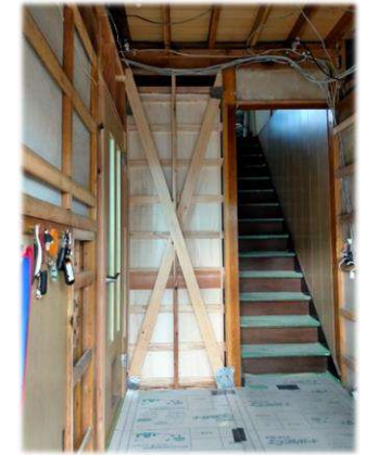
耐震改修工事
