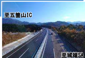
4車線化の一部供用区間
