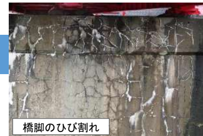
橋梁の老朽化対策 (県道高岡小杉線 南郷大橋の損傷状況)
