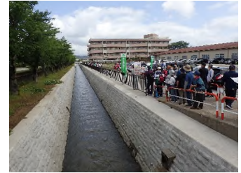
ウォーキングの目玉施設 茶ノ木排水路
