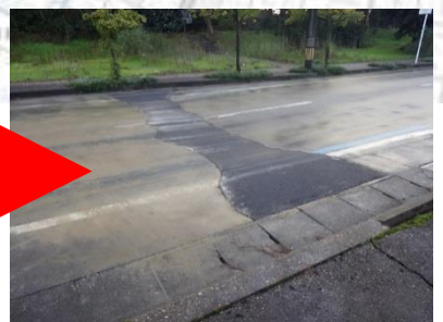
応急対策状況
