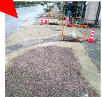
応急対策状況
