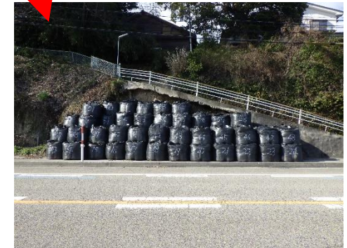
応急対策状況
