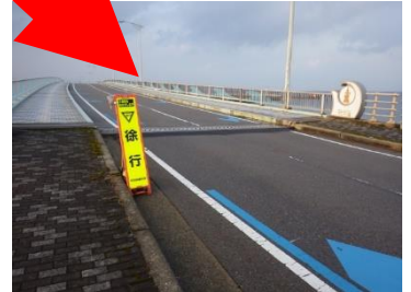
応急対策状況
