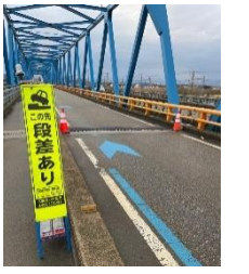
応急対策状況
