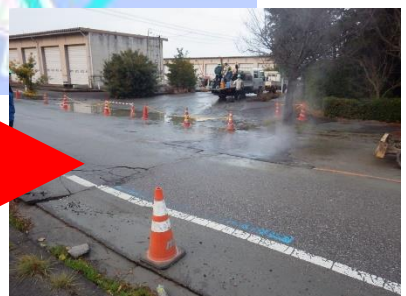
応急対策状況
