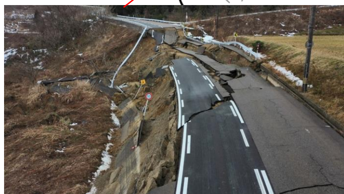
崩落した国道359号 (小矢部市)
