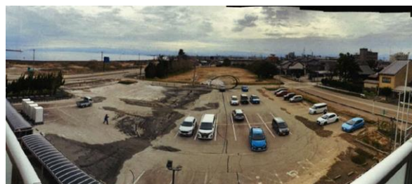
液状化被害 (高岡市)
