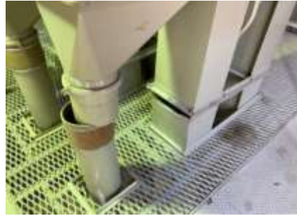
カントリーエレベーター昇降機の破損
