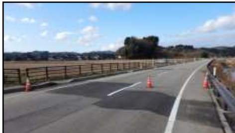
応急対応 （舗装段差擦り付け）
