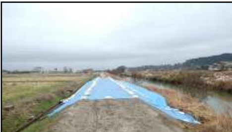
応急対応 （ブルーシート設置）
