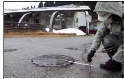
下水道の被災調査支援
