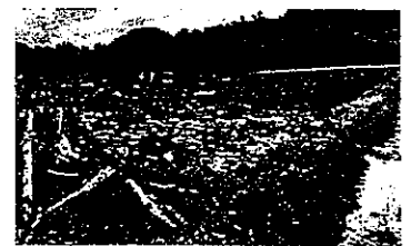
白岩川堤防決壊により水田に流木、土砂が堆積
