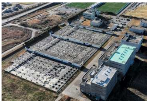
神通川左岸浄化センター
