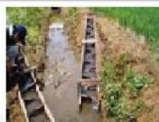
水田水路の設置
