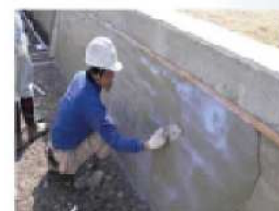
老朽化した水路壁のコーティング
