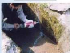
水路のひび割れ補修
