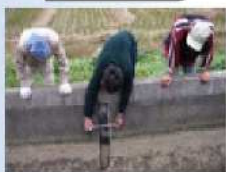
施設の機能診断
