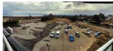
液状化被害（高岡市）
