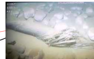
海洋深層水取水管断絶（入善町）
