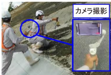
現場での受注者による計測状況
