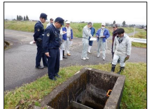
関係者による危険箇所点検
