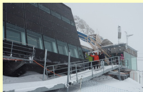
山頂ターミナルの壁一面に設置されたソーラーパネルにより施設の電気が賄われている
