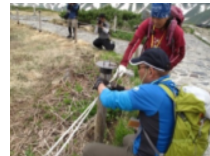
長野県サポートとの保護柵設置
