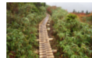
植生に配慮した木道整備
