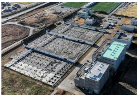
神通川左岸浄化センター
