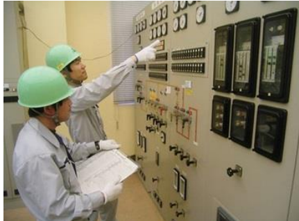
発電所点検作業
