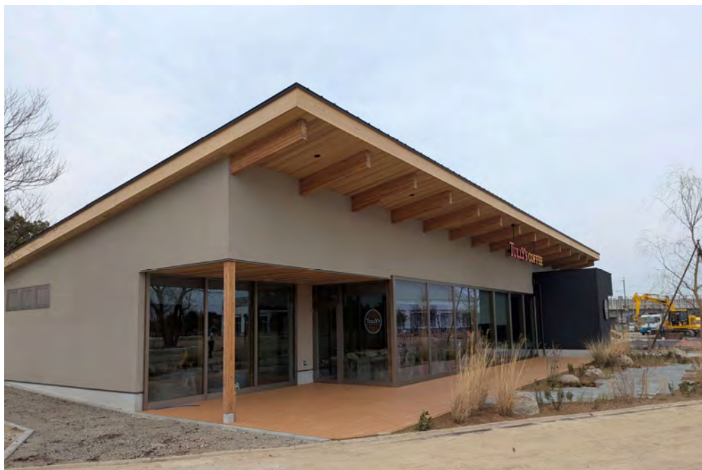
タリーズコーヒー高岡おとぎの森公園店（高岡市佐野新町） 外装、内装木質化
