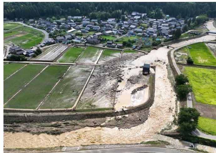
白岩川の護岸欠損による被災状況
