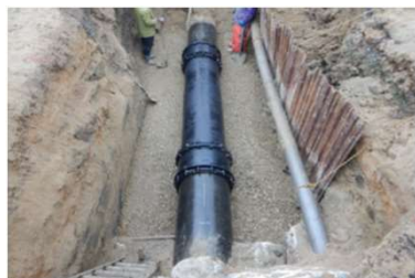
農業用水パイプラインの復旧
