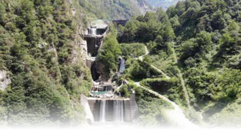
白岩堰堤（重要文化財）
