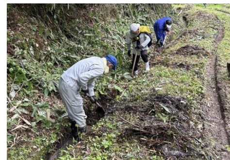
農業用水路の土砂上げ作業
