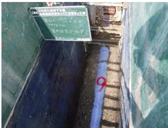
開削区間 PRP管 \phi 350 設置状況
