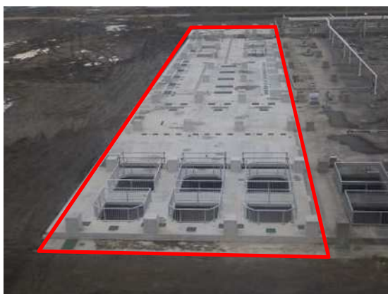
外観 (最初沈殿池、反応タンク、最終沈殿池)
