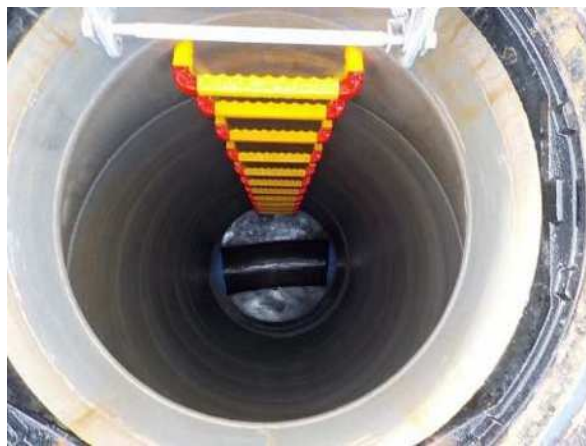
マンホール設置状況
